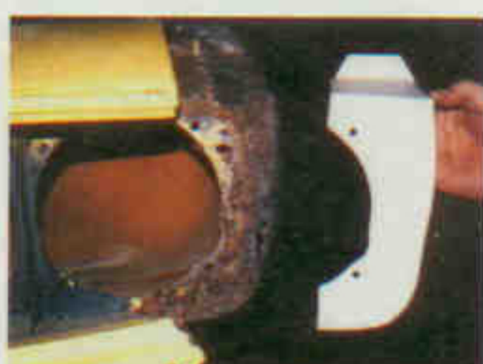
Selbst ist der Mann: Viele Reparaturbleche waren Eigenbau
